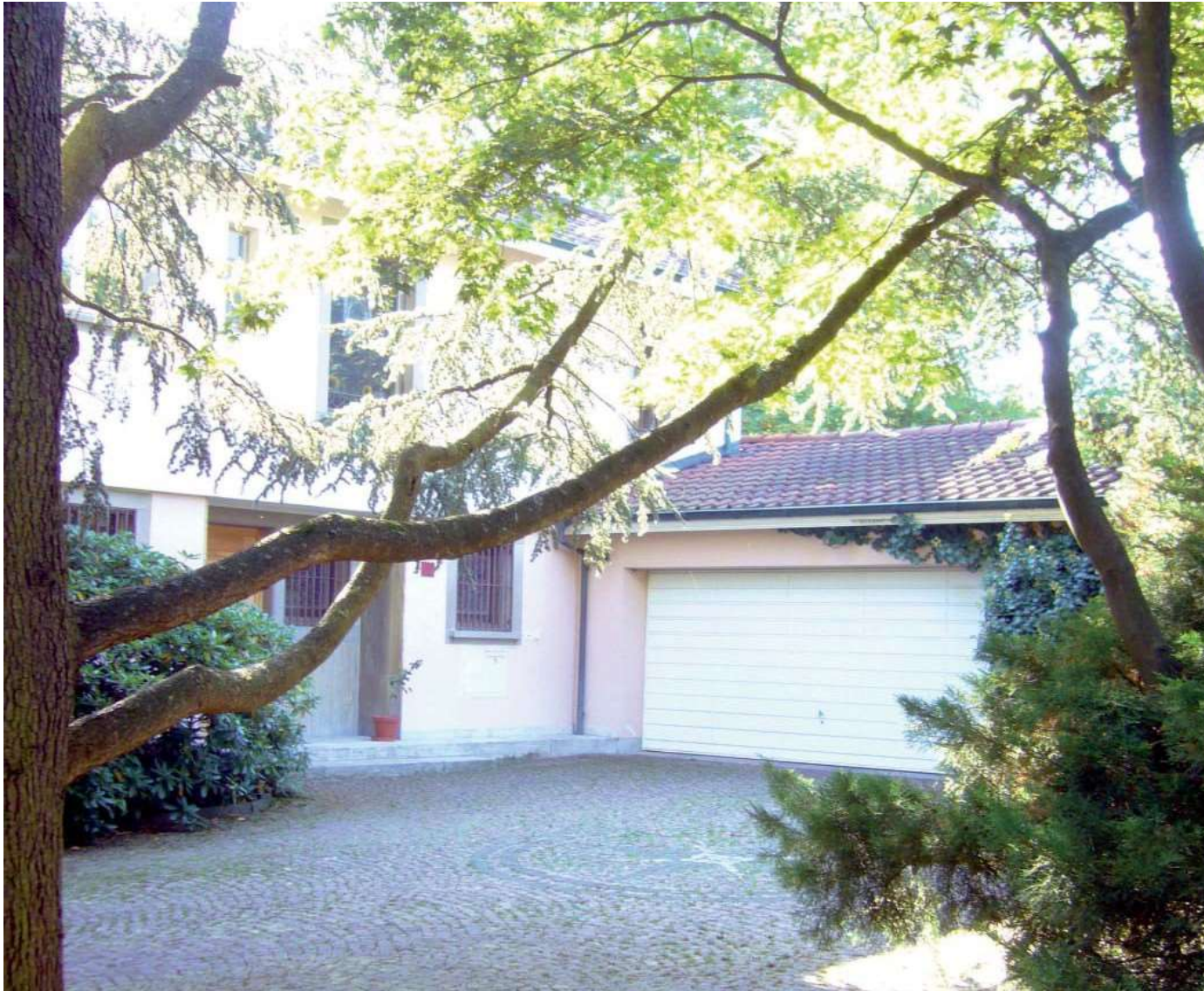
Vorplatz mit angebauter Doppelgarage
